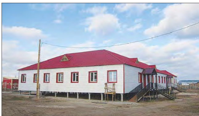
Рис. 7. Типовые модульные участковые больницы в Республике Саха (Якутия), построенные в селах Хатырык, Хантагай, Черкёх, Кеттени; п. Жатай Fig. 7. Standard modular district hospitals in the Republic of Sakha-Yakutia
