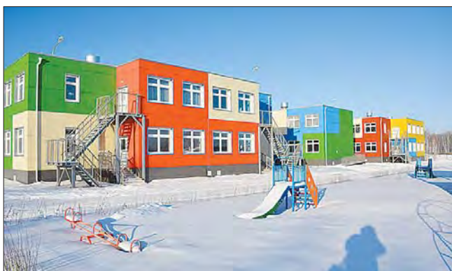
Рис. 10. Детский сад на 240 мест в г. Миасс, Челябинская область Fig. 10. Kindergarten for 240 places in Miass, Chelyabinsk region
